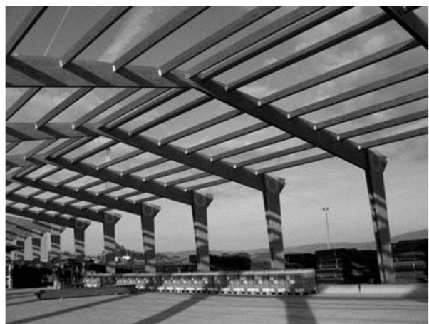
Figura III: Esqueleto estrutural em madeira
