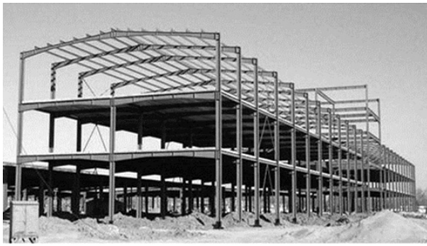
Figura I: Esqueleto estrutural em aço
