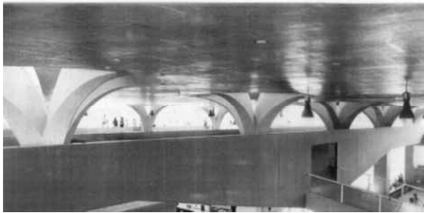
rodoviária de Jaú, 1973, Villanova Artigas
