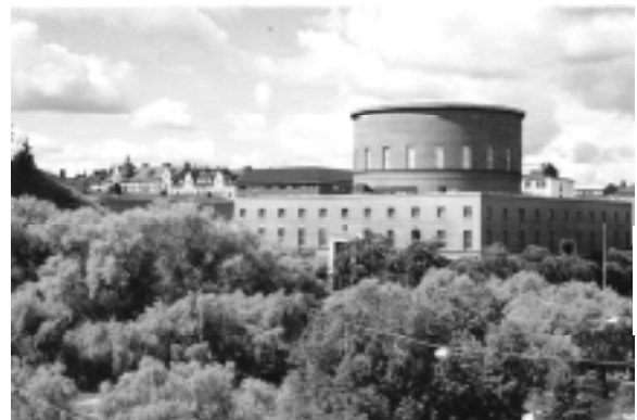
Biblioteca de Estocolmo: Vista Externa
