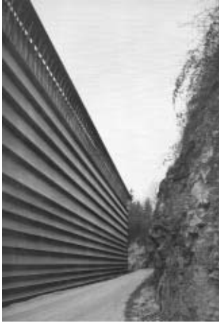
Armazém para a Fábrica Ricola, Laufen, Suíça (1986-87)
