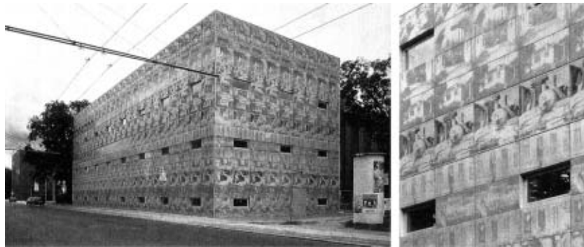
Biblioteca da Escola Técnica em Eberswalde, Alemanha (1994-97)
