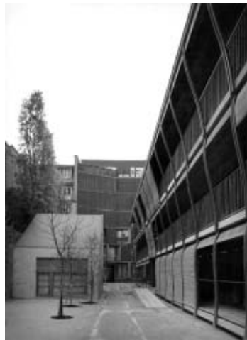
Edifício Habitacional em Paris, França (1996-2000)
