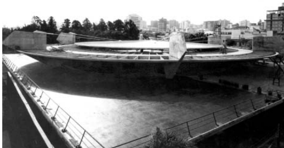
Vista do Ginásio com Esplanada elevada em primeiro plano.
