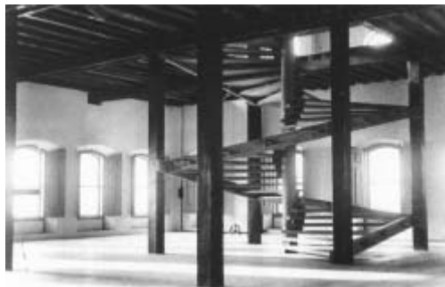
Nova escada realizada com o sistema de encaixes dos carros de boi, Museu de Arte Popular, Solar do Unhão, Salvador, BA, 1959
