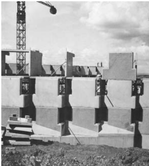
Execução da obra
