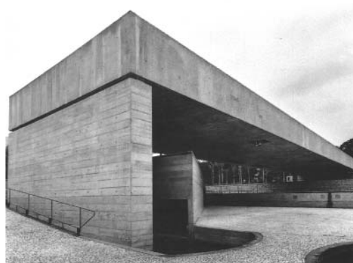
Vista da Grande Cobertura e Bloco de Apoio
