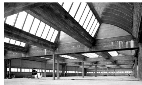
Sheds da Casa de Impressão MAME, Tours, 1950
