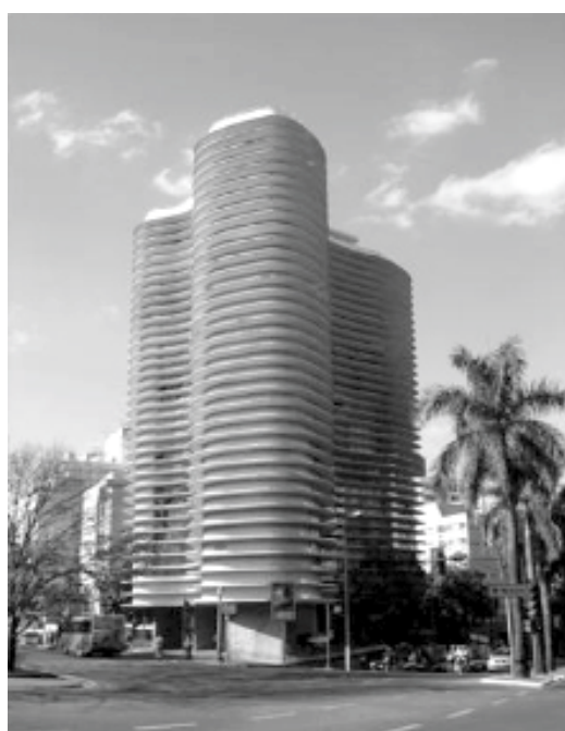
Vista geral do edifício
