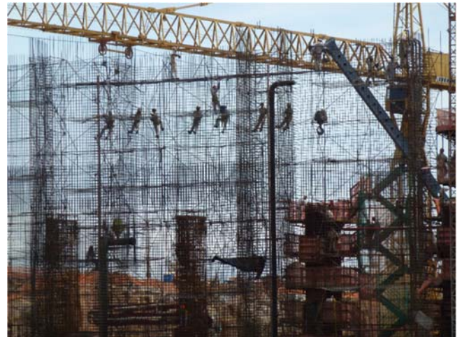
"Acrobatas de Santo Antônio"- Operários no canteiro de obras da Usina Hidrelétrica de Santo Antônio (2012)
