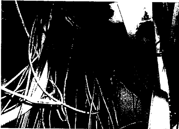
Figura 11(a) - Cabos de rede de computadores desorganizados
