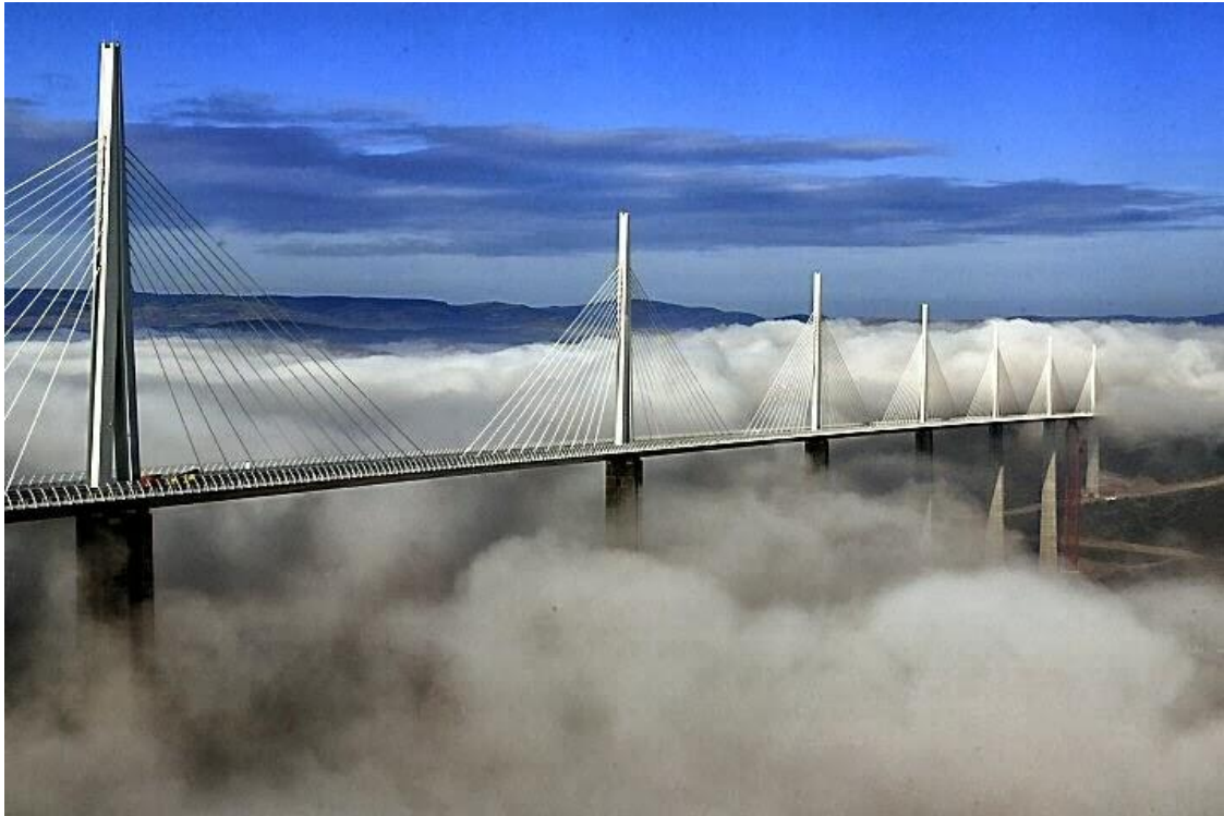
O viaduto rodoviário sobre o Tarn, na Provença, França (2004)
