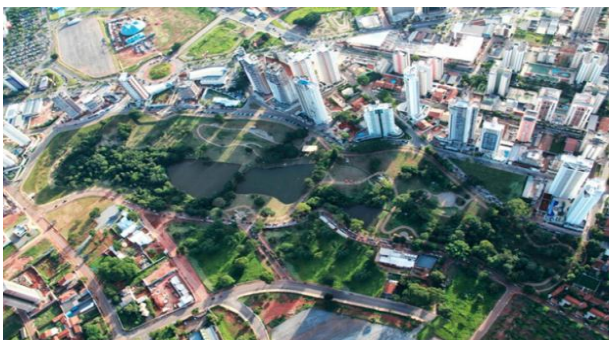
Imagem 2 – Vista aérea do Parque Flamboyant - Goiânia
